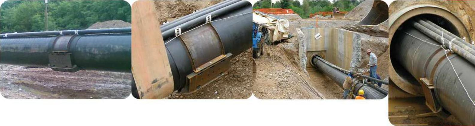
La **possibilità opzionale** di dotare il cofano superiore della **GUAZZISLIT®** di un **supporto per le tubazioni secondarie** consente un ulteriore risparmio economico, oltre alla fondamentale riduzione dei rischi in materia di sicurezza. Infatti, preinstallando i tubi secondari direttamente all'esterno del tunnel, si ha una ulteriore riduzione dei costi di cantiere legati al fatto che non sono più necessarie le seguenti lavorazioni:
